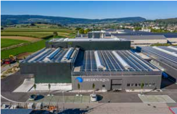
Anlage in Büsserach mit Photovoltaikanlage
