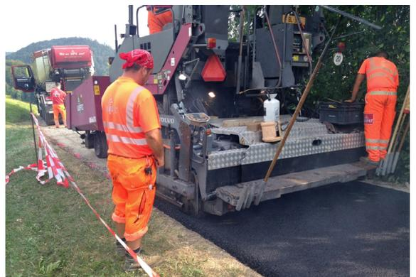
weil die Firma Wirz den Einbau mit neuer Technologie vornahm. Dabei wird beim Vorheizen des Belages nicht mehr mit Gas gearbeitet, sondern die nötige Wärme elektrisch erzeugt.
